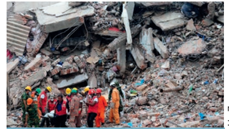
Les secours après l'effondrement.
